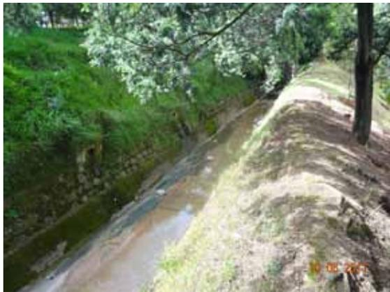
**Fotografía 3. Sección hidráulica del canal con taludes en tierra, SER-SDA, 2017**
