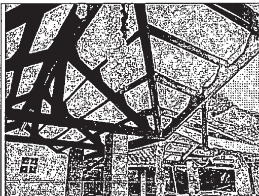
Foto 13. Estructura en madera de soporte de la cubierta.
