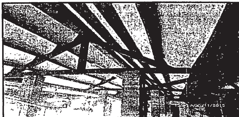
Fotografía 9. Entramado en madera de las cubiertas de cada bloque de la Plaza de mercado Rumichaca en el predio de la Carrera 3 Este No 7-20, en el Barrio Egipto, de la Localidad de La Candelaria.
