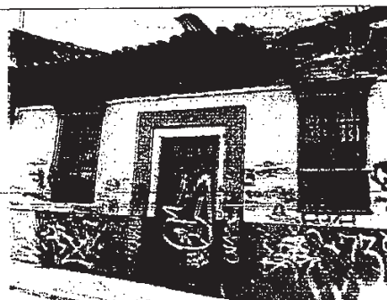
Fotografía 18. Fachada de la vivienda del predio P4, en el Sector Catastral La Catedral.
