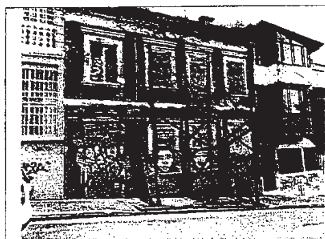
Fotografía 25. Fachada de la vivienda del predio P6, en el Sector Catastral Las Aguas de la Localidad de Candelaria.
