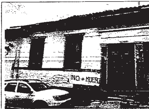
Fotografía 1. Fachada de la edificación del predio P1, en el Sector Catastral La Concordia.
