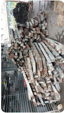
Tubería de 2" y 3" y Parales Av. Villavicencio con Cl 53 al sur. Acta de entrega firmada el 13 de marzo de 2026.
