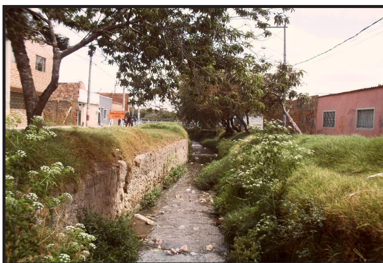
Tramos de la Quebrada Limas con muros de contención improvisados por vecinos del sector por inundaciones varias sufridas por los habitantes aledaños al sector
